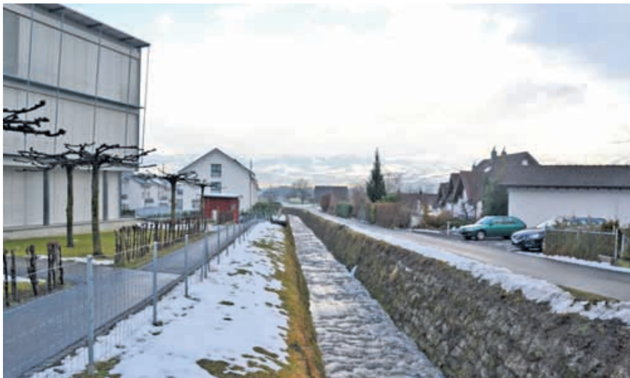
In ein enges Bett gezwängt: der Rütibach in Reichenburg. Bis Ende 2013 mussten die Kantone dem Bund den Entwurf einer «strategischen Revitalisierungsplanung» für Fließgewässer einreichen. Bild Archiv
